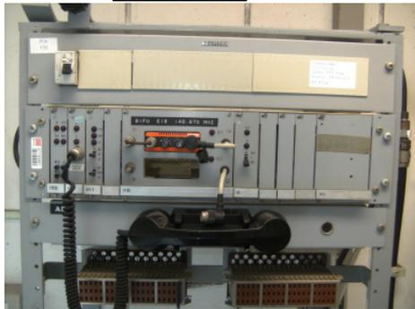
Mobilfunkgeräte benutzt sondern sogenannte Funkmagazine der Firma AEG-Telefunken. Ein solches Funkmagazin ist auf dem Foto links zu sehen. Es enthält die Tonrufauswertererschaltung sowie die Anpassung an eine Drahtleitung zum jeweiligen Stellwerk. Diese wurde benötigt wenn die ortsfeste Funkstelle sich nicht am Standort des Stellwerkes befand - so wie in diesem Fall hier. Es handelt sich um Aufnahmen der Funkstelle im Bf. Bochum-Dahlhausen,
